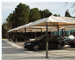
Aparcamientos para la U.M.E.
